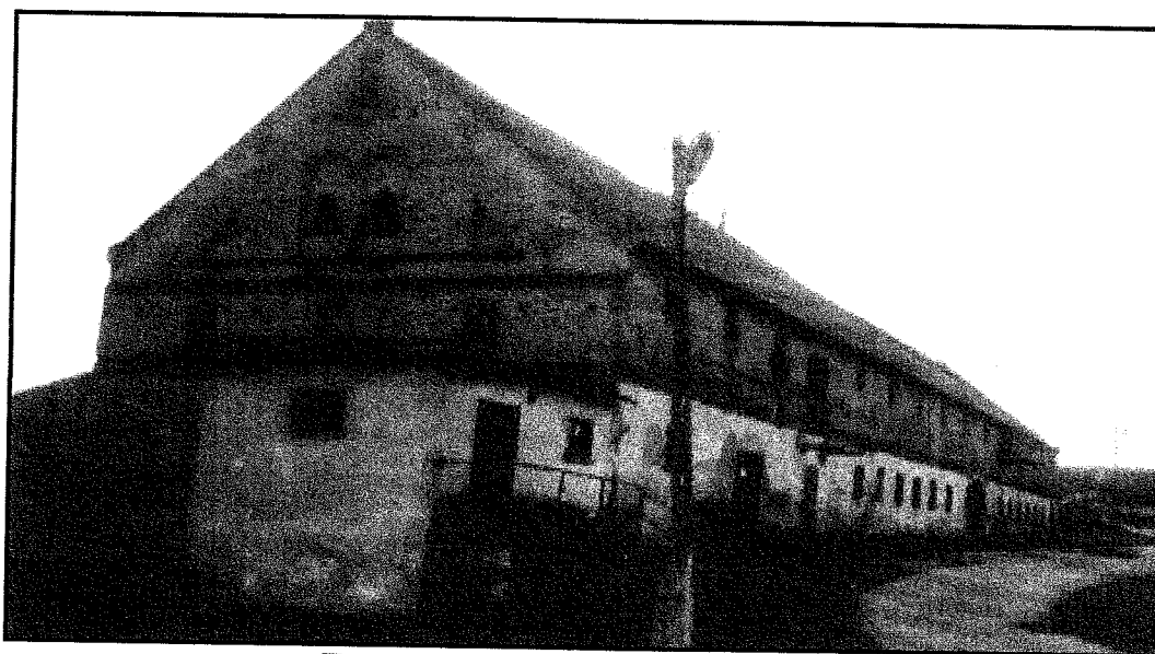
Fot.10. Dawny budynek stajni
