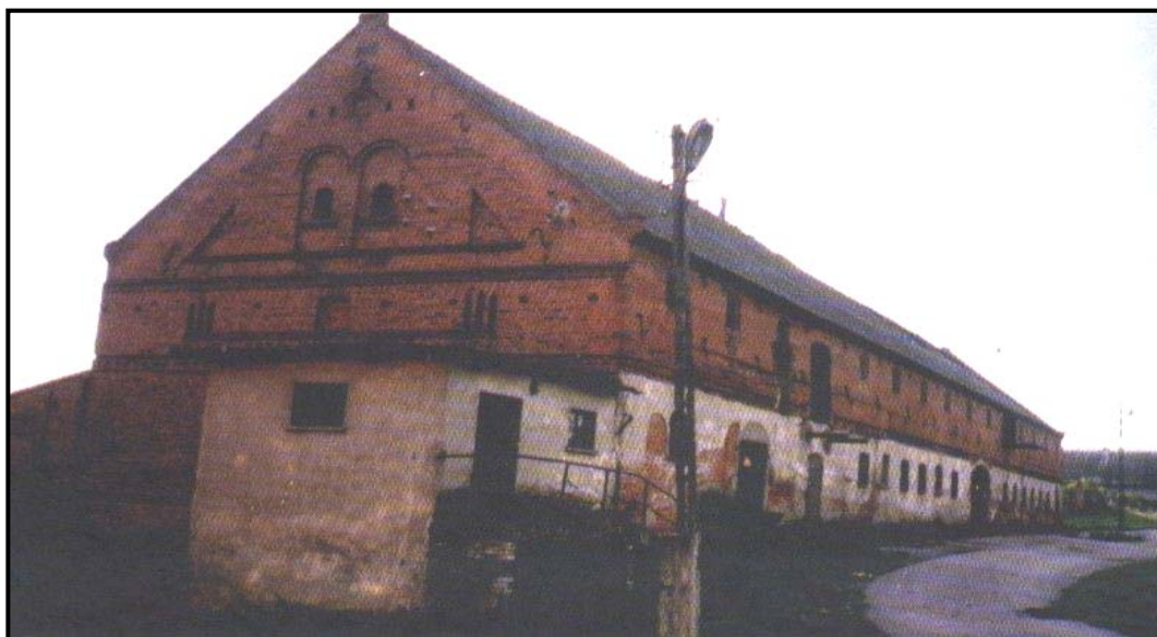
Fot.10. Dawny budynek stajni
