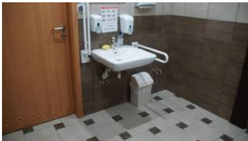
Toaleta dostosowana do potrzeb osób z niepełnosprawnościami
