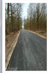
Droga nr 090114C Wyrza - Witosaw
