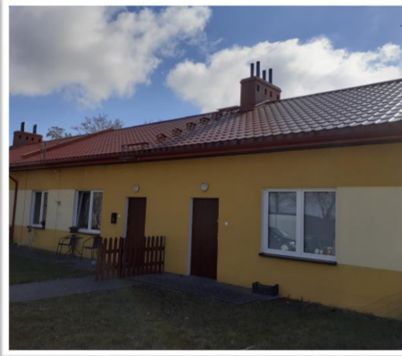
Zdjęcie nr 5. Budynek wybudowany przy ul. Dworzec 1C w Mroczy.
