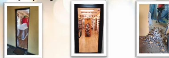
Wymiana drzwi wejściowych do biblioteki
