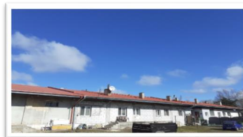
Zdjęcie nr 4. Wymiana pokrycia dachowego: Mrocza ul. Dworzec 1.
