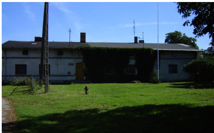
Fot.5. Pozostałości zespołu folwarcznego w Drażnie.
