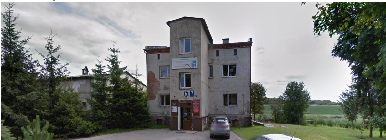
Fotografia 2 Widok budynku MGOPS
